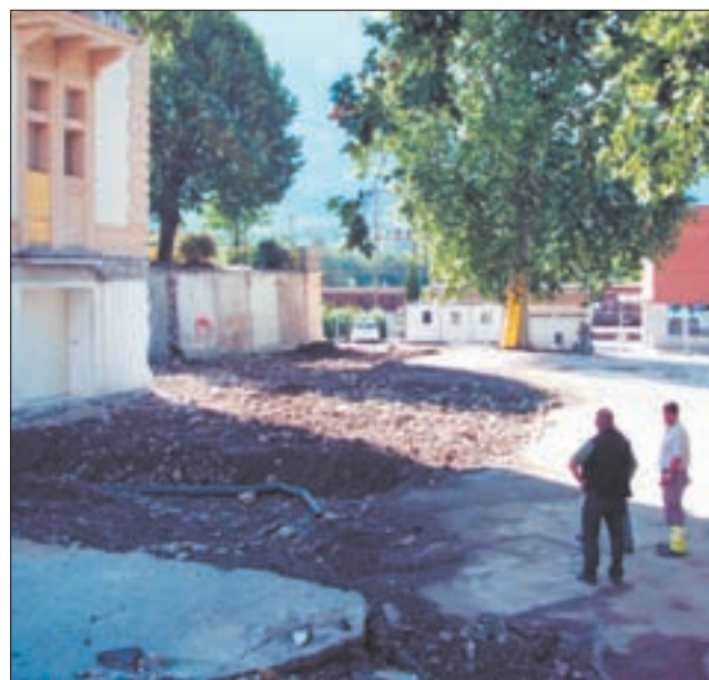
La construction du bâtiment de la police peut débuter. DR
