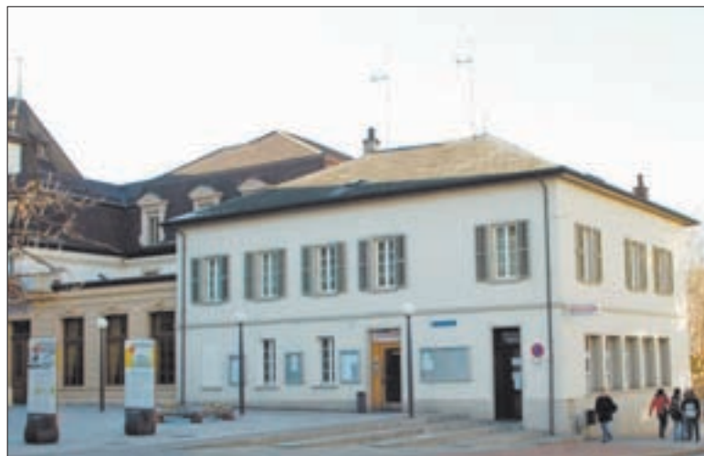
L'ancien bâtiment de la police ne sera pas détruit. Il subira des transformations et pourrait servir de locaux administratifs à la commune de Sierre. ARCHIVES NF
