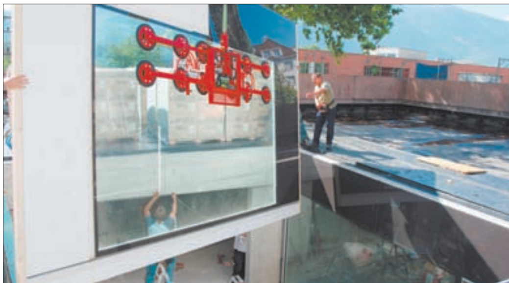
La Maison Tschopp-Zwissig a installé les fenêtres en verre collé. Une opération délicate. DR
