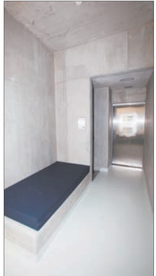
Deux cellules de dégrisement, au confort spartiate, ont été intégrées au poste de police. Il n'en existait pas dans l'ancien commissariat. REMO
