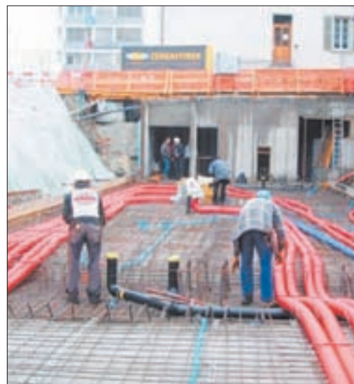
La partie nord du bâtiment où sont situés le garage et les cellules de dégrèvement. DR
