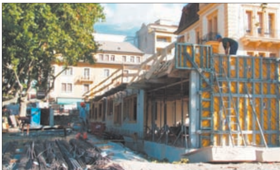
Les ouvriers s'affairent. Le poste de police prend forme petit à petit. DR
