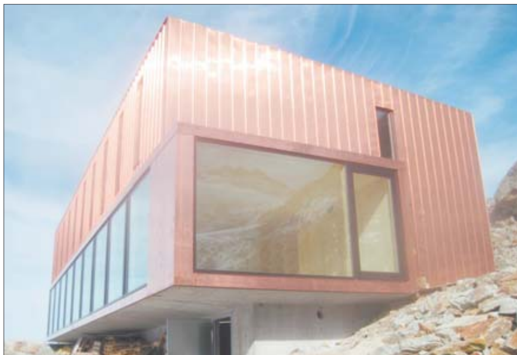
Le nouveau volume de Moiry se situe dans le prolongement de l'ancienne cabane. Le revêtement de la façade est en cuivre. On y retrouve notamment un réfectoire panoramique et des dortoirs. La capacité totale de la cabane passe de 88 à 101 couchettes. LDD
