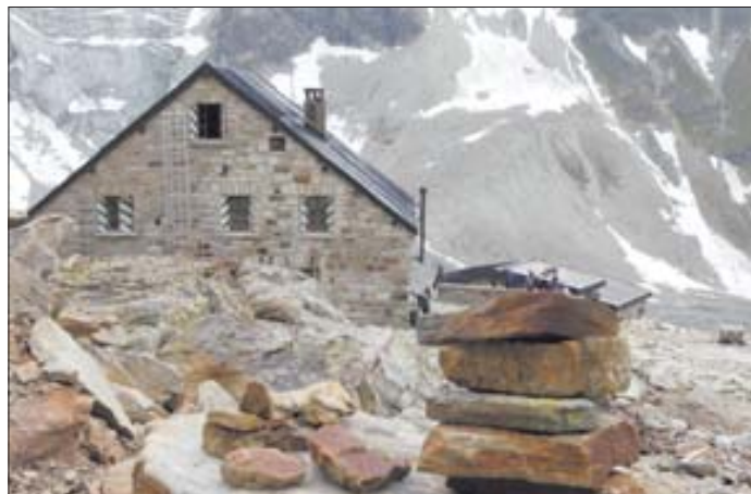
L'ancienne cabane de Moiry a été rénovée. Les dortoirs et les escaliers ont été améliorés, le réfectoire transformé en local de réunion et de formation. ARCHIVES NF
