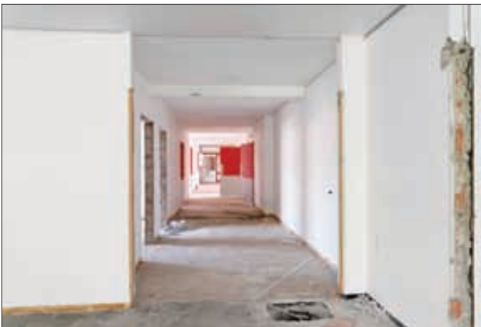
Le bâtiment a été totalement rénové. L'ancienne structure porteuse a été gardée à 95% et renforcée. Toutes les autres structures ont été changées. L'aile a été détruite. PIERRE ZUFFEREY
