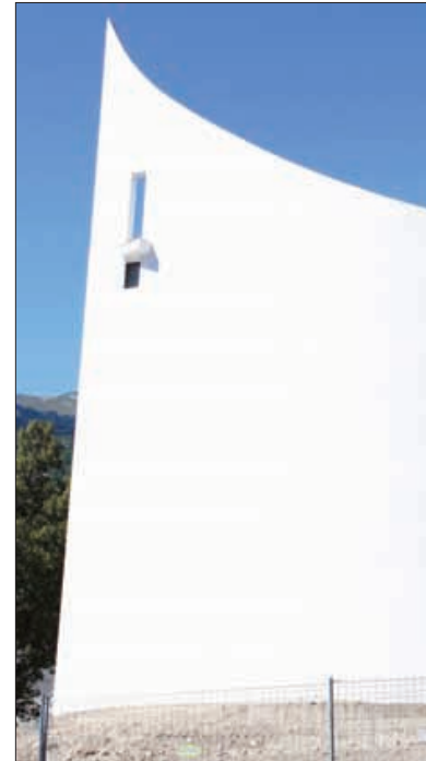
Les travaux de rénovation auront duré deux ans. Hormis quelques détails, notamment au niveau des aménagements extérieurs, tout est terminé. REMO
