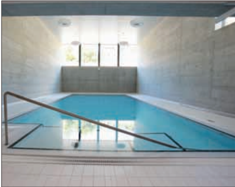
La piscine fait désormais partie intégrante du bâtiment. Ce bassin thérapeutique de 72 m 2 est adapté aux enfants de l'Institut et pourra aussi, à l'avenir, servir pour des thérapies externes. REMO
