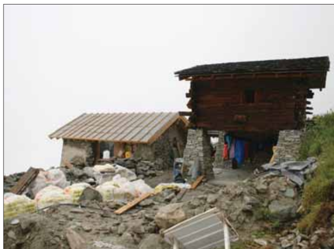
Le hameau du Chiesso, au-dessus de Zinal, comprend quatre bâtisses en cours de rénovation. DR
