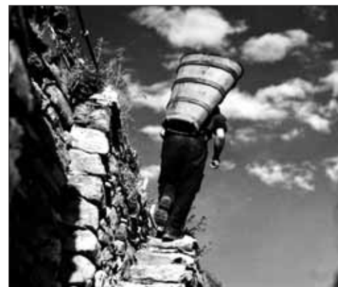
Escalier en pierres sèches, 1940-1950.
