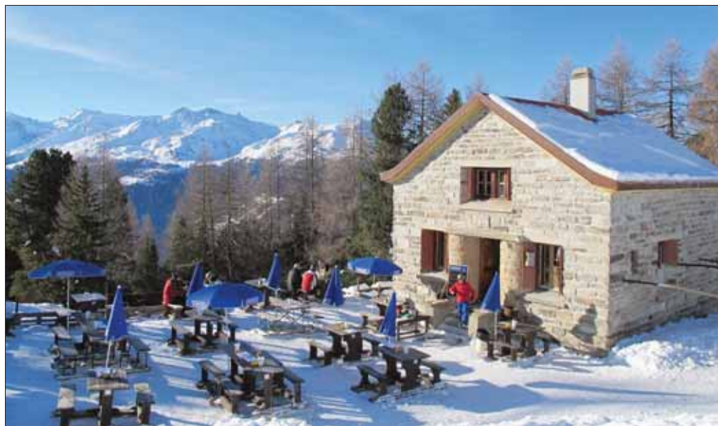
La cabane de l'Illhorn sera assainie. Une nouvelle structure sera construite sous la terrasse actuelle. LE JDS
