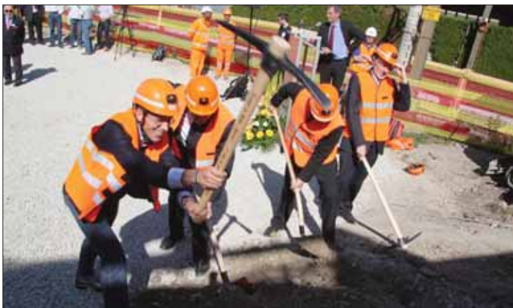
La semaine passée, les autorités et les CFF ont donné le 1er coup de pioche du nouveau tunnel du Gobet qui traverse Sierre. Le chantier de 58,8 millions de francs, devrait être terminé en 2015. MAMIN/NF
