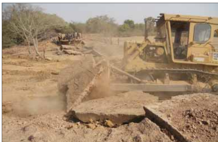
La réfection de la vieille digue de Petit Samba a été réalisée en mars 2012. LDD
