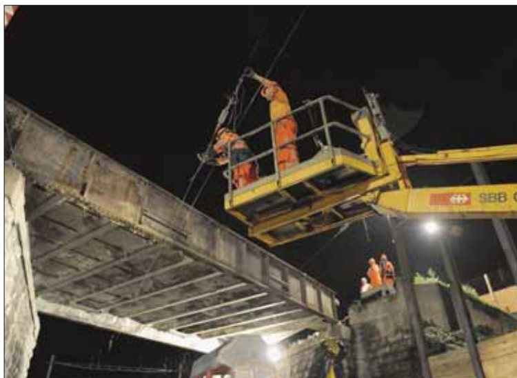
Fin août à Sierre, un important chantier nocturne a occupé les CFF et des entreprises spécialisées. Objectif: enlever le pont de Glarey, au-dessus de la ligne du Simplon. BITTEL/NF
