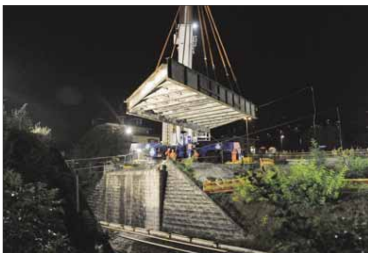
Grâce à une immense grue hydraulique, le pont de Glarey, bébé de plus de 100 tonnes, a pris la voie des airs. Il a ensuite été réduit en morceaux et envoyé à la ferraille. BITTEL/NF
