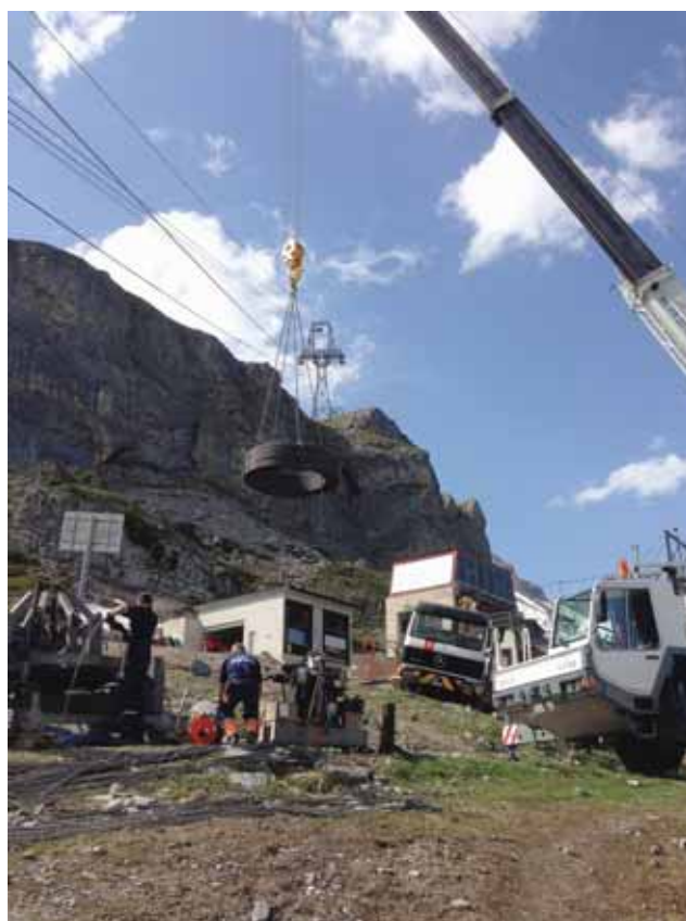
Le câble du Funitel, à Crans-Montana, a été remplacé après 18 ans de service. Il pèse plus de 130 tonnes. Ici aussi, un convoi spécial (début juin) a été nécessaire. Le chantier est terminé et le Funitel est à nouveau en service. CMA
