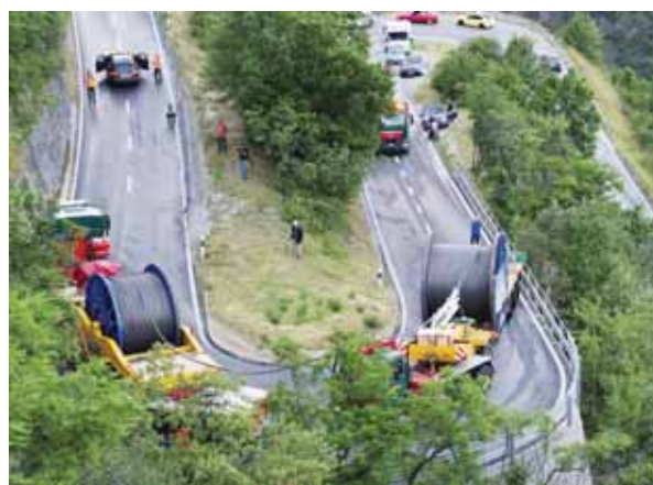
La construction du téléphérique Grimentz-Zinal nécessite des mesures extraordinaires. Tous les mardis soir de juillet, un convoi de 173 tonnes grimpe à vitesse de fourmi la route du val d'Anniviers. BITTEL/NF
