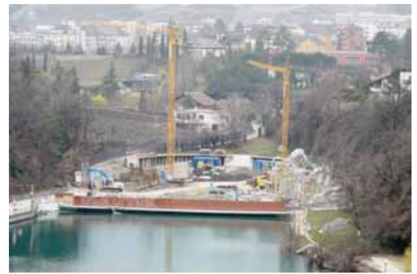
Avril 2013: les grues ont pris possession des lieux. Le chantier est imposant. NF
