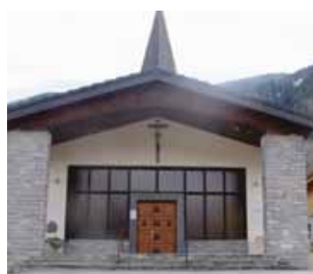
La poutre en béton qui réunissait les deux colonnes de l'entrée de la chapelle a été supprimée. LE JDS
