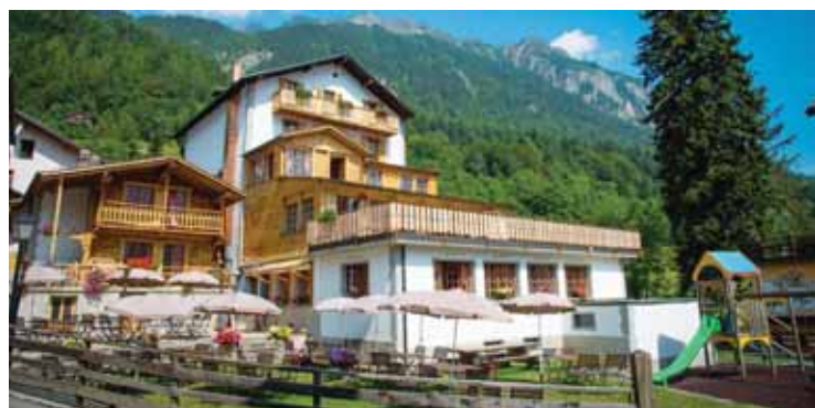
La maison de vacances qui a été acquise par Insieme aux Marécottes. LE JDS
