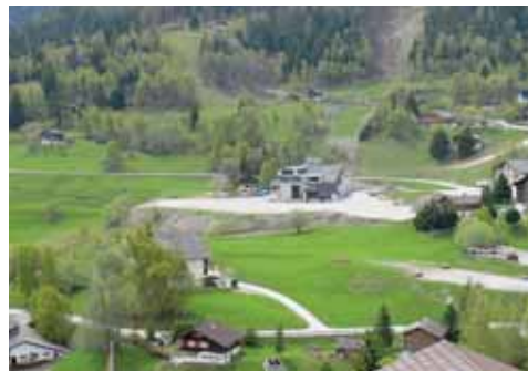
La bâtisse sera construite à côté de la télécabine de Vercorin. LEJDS
