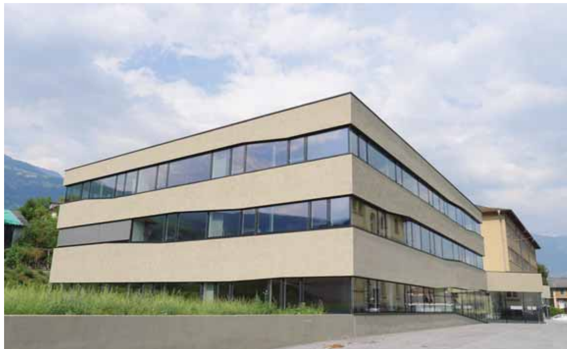
Avec l'école de Borzuat, la commune a voulu vouloir faire un bâtiment exemplaire sur le plan énergétique. DR
