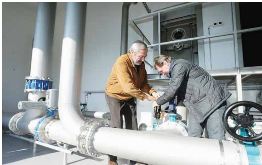
François Genoud, président de la Ville et Mario Rossi, conseiller communal en charge du dicastère environnement, eau et énergie, ouvrent les vannes du nouveau réservoir. REMO
