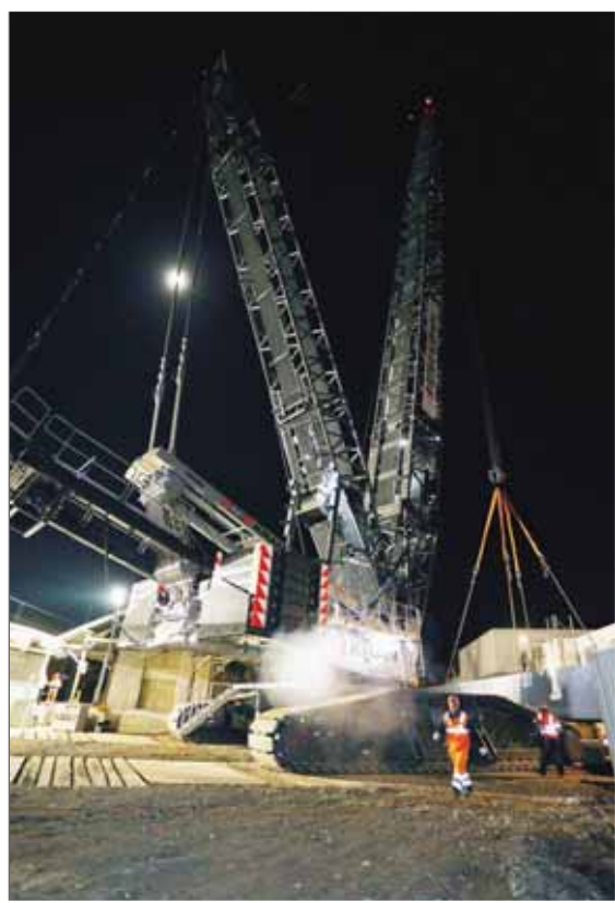
L'ouvrier paraît bien petit à côté de la gigantesque grue qui pèse 800 tonnes. Rien que ses deux chenilles affichent 9 tonnes sur la balance... REMO
