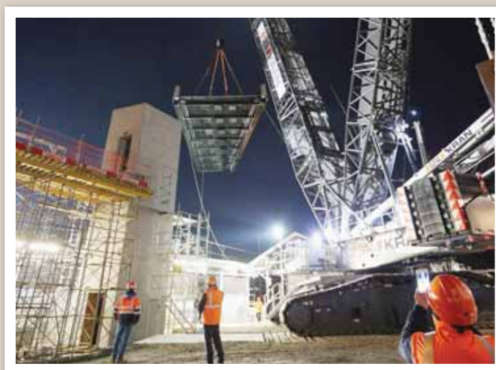
Les piliers attendent la seconde passerelle. Les deux structures formeront un trait d'union entre la nouvelle gare routière et le centre de la ville, entre les nouvelles zones résidentielles de Condémines et le cœur de la ville. REMO
