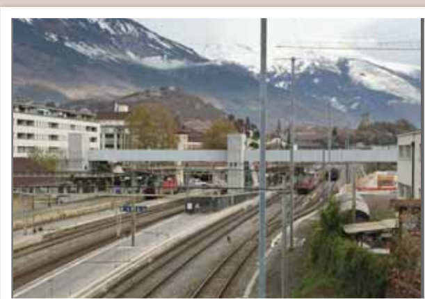
Le résultat de cette opération gigantesque: une passerelle de 85 mètres de long. REMO
