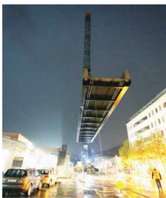
La grue soulève la seconde passerelle de 66 tonnes comme on soulèverait une feuille de papier. REMO
