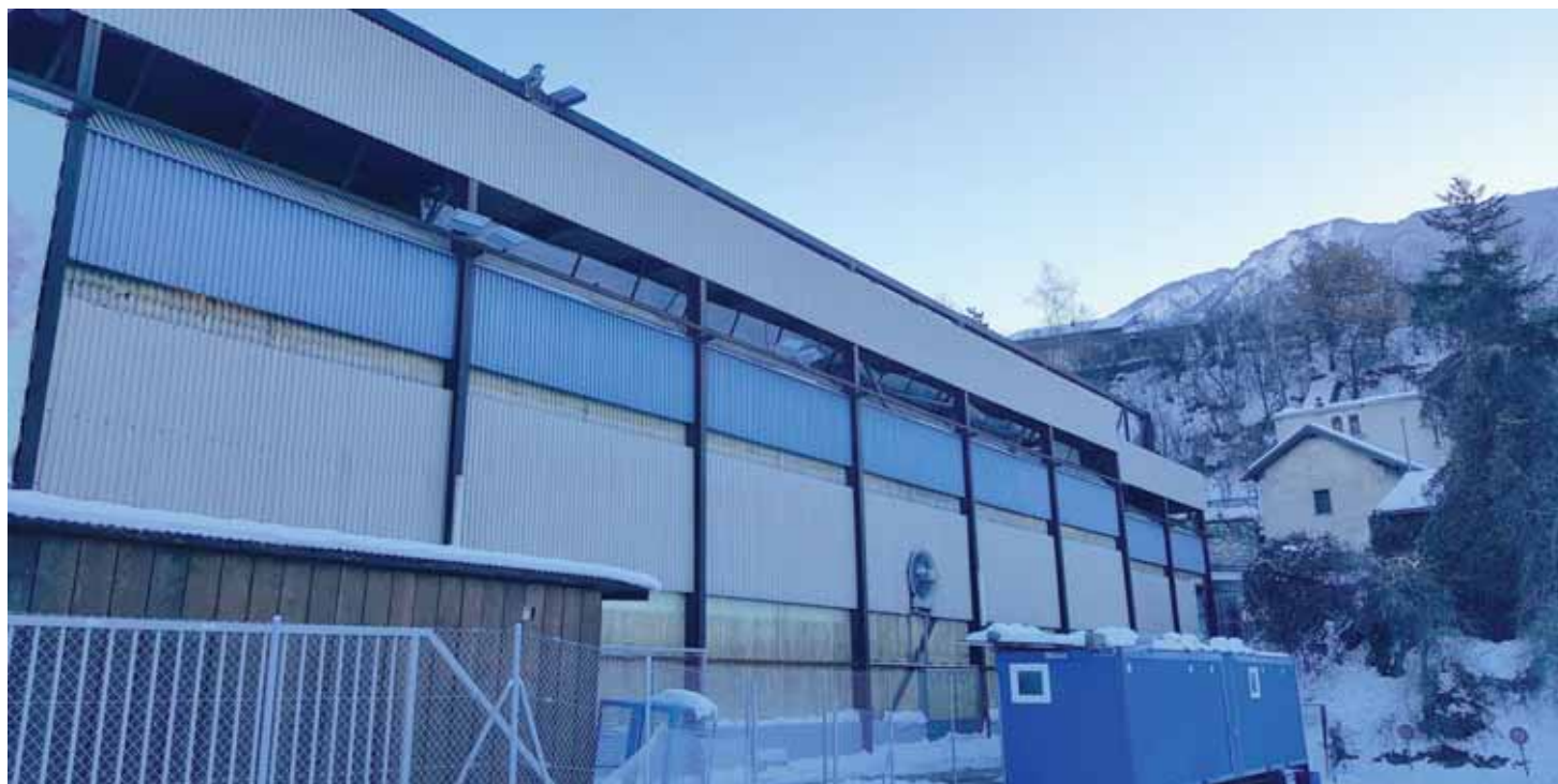
La patinoire de Graben, version hiver 2017-2018. Non seulement le bâtiment se situe sur le tracé de la future route qui devrait désengorger le centre-ville, mais il est devenu totalement obsolète. LE JDS
