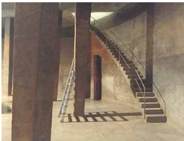
Particularité de l'ancienne cuve: des escaliers permettaient d'y descendre. Avec les nouvelles normes, ils ont été supprimés. DR
