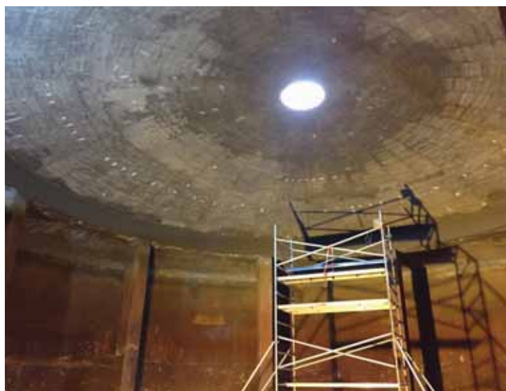
La structure même du réservoir n'a pas été touchée. Les murs et la coupole d'origine ont été conservés. DR
