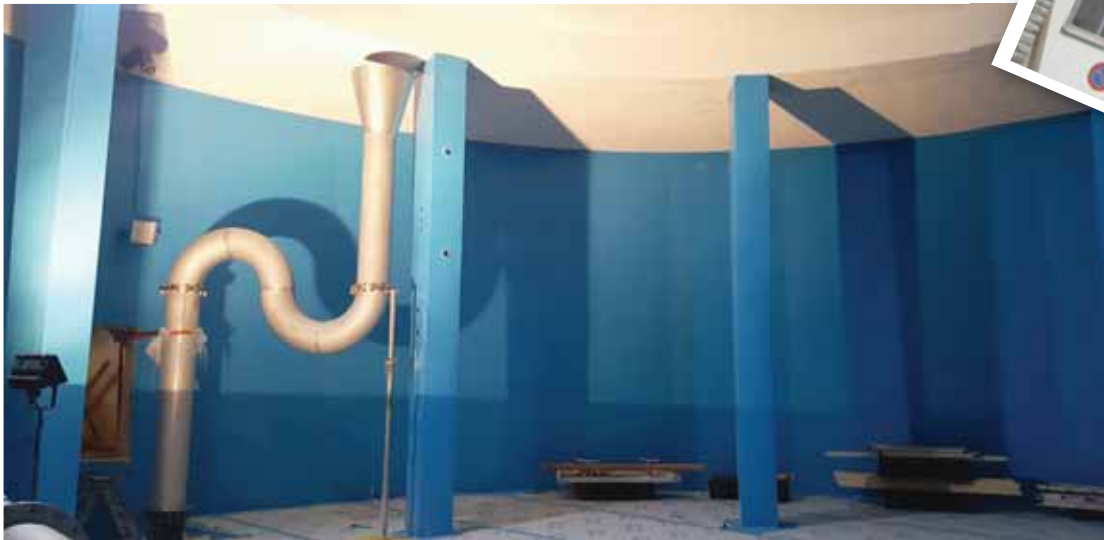
Des plaques de polyéthylène recouvrent les parois et le sol. Le réservoir de Muraz est le plus grand de Suisse romande à être équipé de cette matière. Ce système laisse passer la condensation. LEJDS
