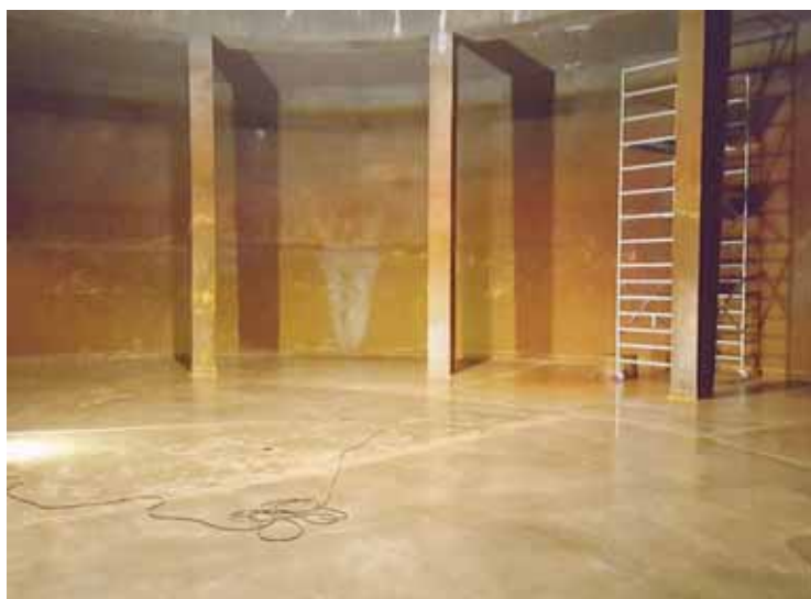
Les installations datant de 1956 avaient de l'allure. Soixante ans plus tard, il était cependant temps de les rénover. DR
