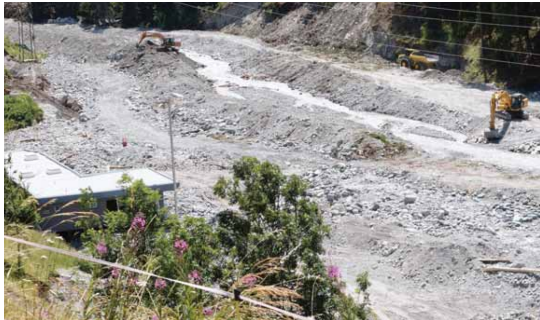
Sur le terrain de football, les travaux pour réendiguer la rivière, sécuriser les zones à risque et protéger la ligne à haute tension ne sont pas encore terminés. REMO
