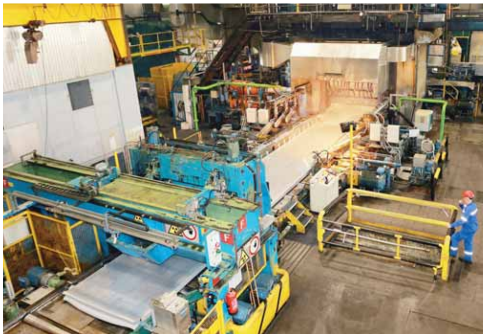
Novelis investira notamment dans un nouveau système de refroidissement et des composants mécaniques pour contrôler la puissance de ses laminoirs à chaud. REMO
