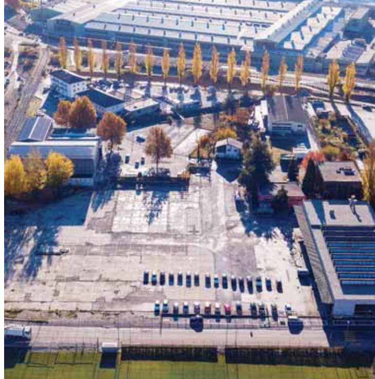
Le quartier de Condémines accueillera la nouvelle patinoire LE JDS
