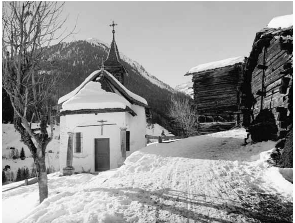
© CHARLES KREBSER, MÉDIATHÈQUE VALAIS-MARTIGNY
