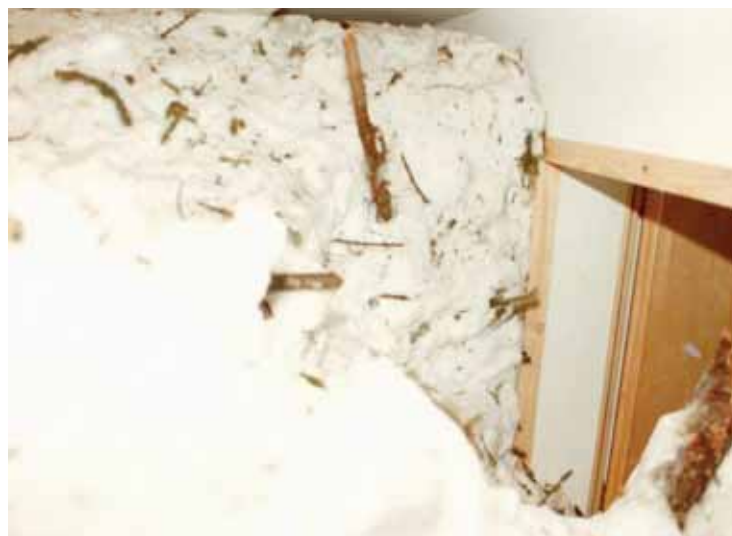
La neige a pénétré dans les studios qui n'ont jamais été remis à neuf. Des occupants s'y trouvaient mais n'ont pas été blessés. DR
