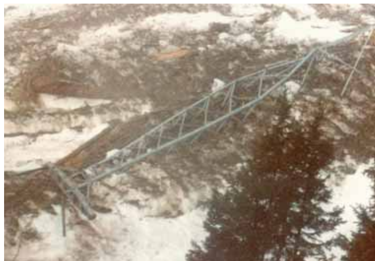
L'un des pylônes de la télécabine a été arraché, le second (photo), écrasé. DR
