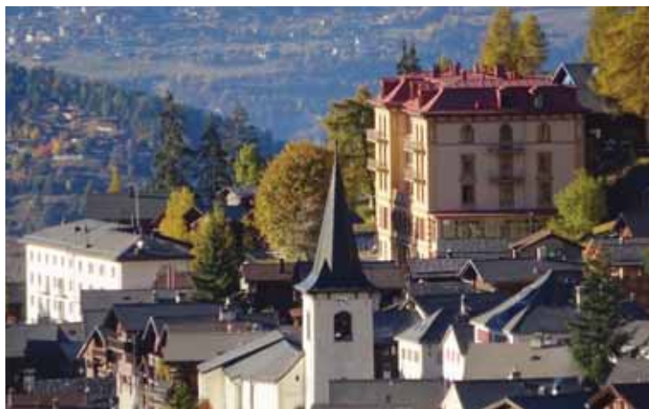
Ce week-end, une dernière visite avant le début des travaux. LE JDS
