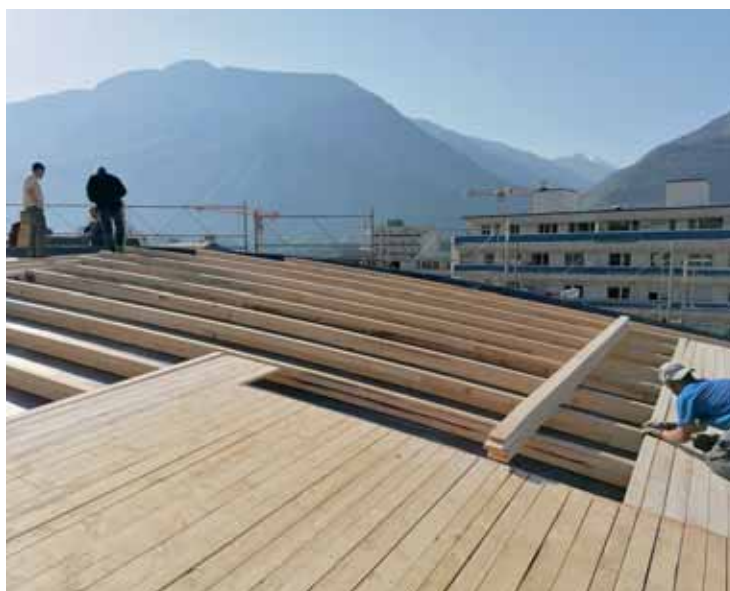
Le toit de l'église Saint-Croix est en réfection mais l'église n'est pas fermée pour autant. DR
