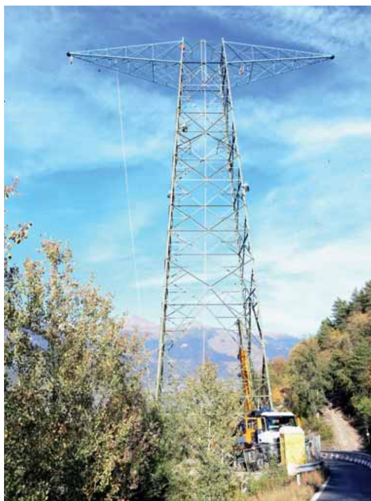
Un pylône en construction sur la route d'Anniviers. REMO
