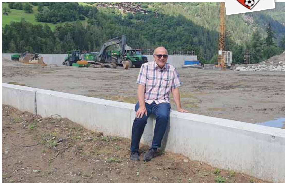
Le président du FC Anniviers, Christian Caloz, sur le chantier du futur terrain du club à Vissoie. REMO
