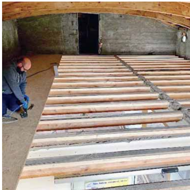
Les travaux de rénovation de la cabane Bella-Tola ont débuté en juin dernier. Tout devrait être terminé à la mi-décembre. DR
