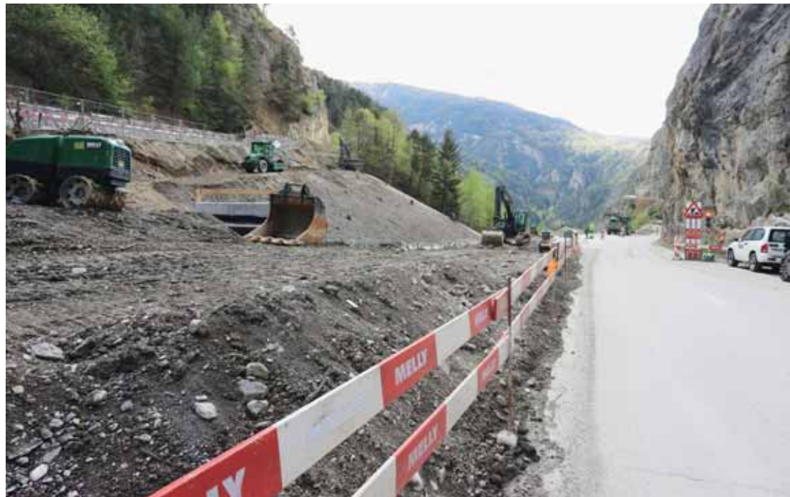
Le lacet des Pontis devra être protégé contre les laves torrentielles grâce à la construction d'un chenal d'évacuation de 40 mètres de long sur la route. REMO
