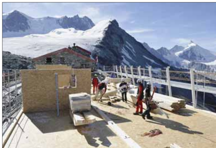
Le chantier de la nouvelle cabane de Tracuit, au-dessus de Zinal, a démarré cet été. Si la météo le permet, les travaux pourraient être terminés en novembre 2012. Montant du projet: 5 millions de francs. BITTEL/NF
