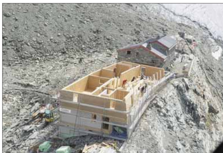
L'ancienne cabane de Tracuit sera détruite. Sa façade sud sera toutefois conservée, pour la mémoire et pour protéger les hôtes du vent violent qui peut souffler à cette altitude, 3256 mètres. BITTEL/NF
