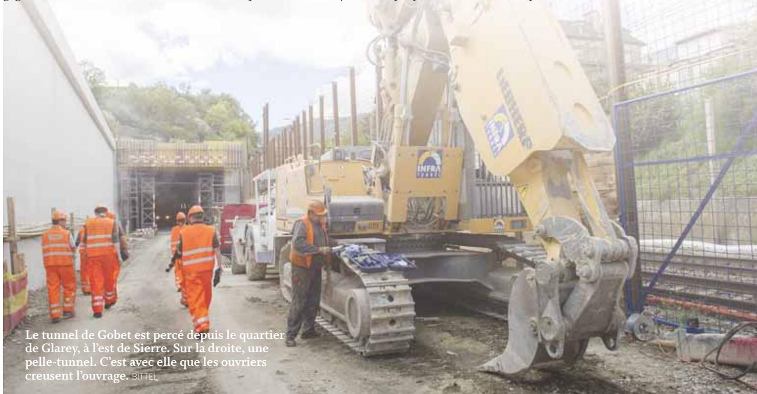
Le tunnel de Gobet est percé depuis le quartier de Glarey, à l'est de Sierre. Sur la droite, une pelle-tunnel. C'est avec elle que les ouvriers creusent l'ouvrage. BITTEL
