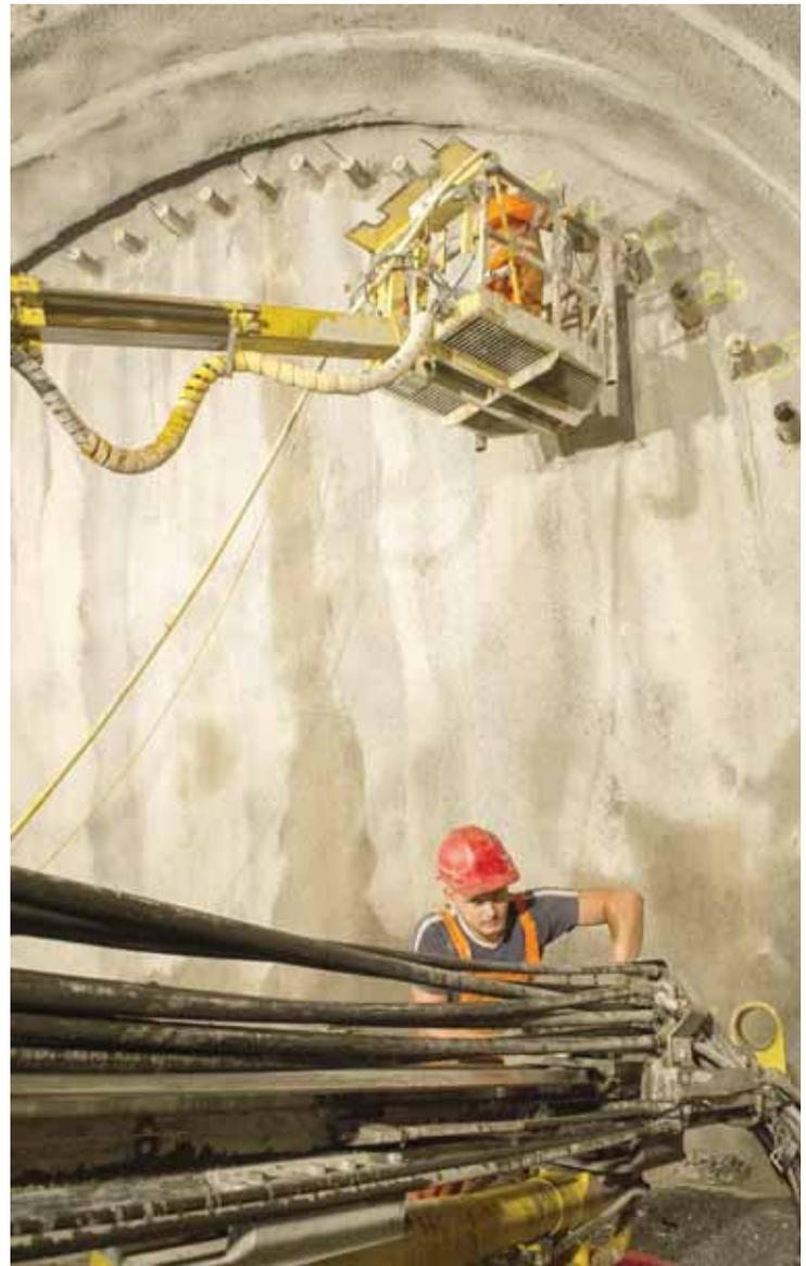
Même si le chantier de Gobet est mécanisé, les ouvriers abattent un travail considérable et très physique: ils creusent, forent, souident, excavent, bétonnent... Avec la technique des voûtes parapluies et cintres, ils avancent de deux mètres par jour. BITTEL
