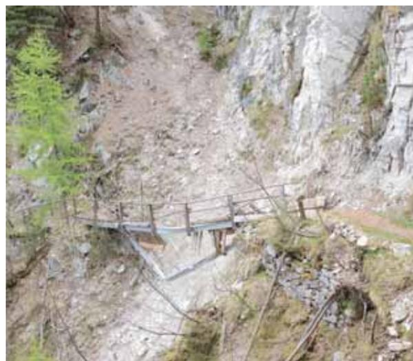
Le pont entre Sousillon et Chandolin a été détruit après un éboulement. Une passerelle métallique le remplacera. LDD
