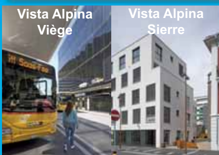
Deux sites; à deux pas de la gare
