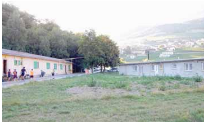
Les anciens vestiaires seront démolis et laisseront la place au nouveau bâtiment, en passe d'être terminé. LE JDS
