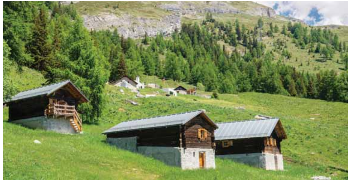
Au final, le hameau comptera sept chalets (trois sont déjà construits), en plus du musée et du relais existants. PHOTO-GENIC.CH
