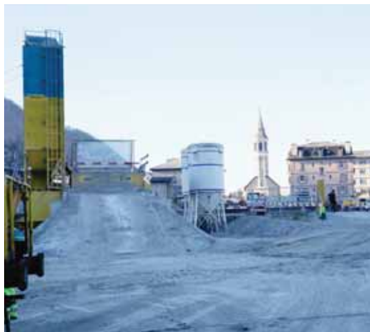
Grâce à une technologie de pointe installée sur place, 60% du total des matériaux ont été excavés, puis employés sur place pour le remblayage des fouilles ou évacués. REMO
